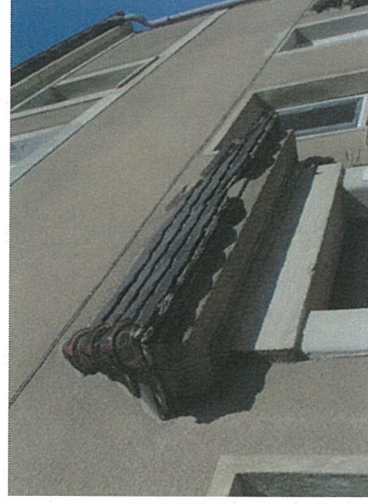
Abb. 11: Bestehendes Vordach, eingedeckt
