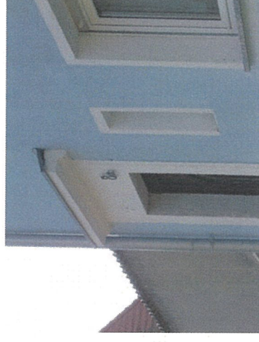
Abb. 12: Saniertes und mit einer Blechabdeckung versehenes Vordach
