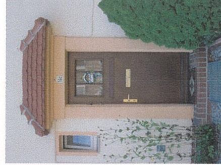
Abb 5: Beispiel für Türgewand mit eingedecktem Vordach
